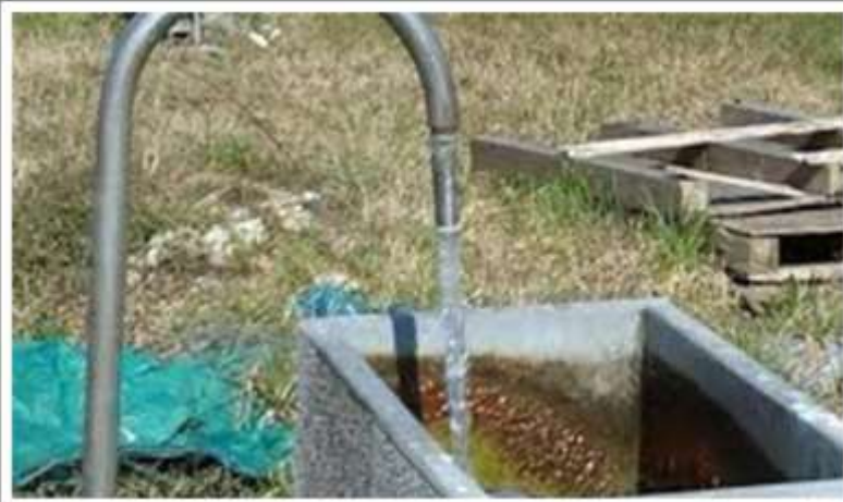
Un pozzo artesiano è un pozzo naturalmente effluente: le acque sotterranee arrivano in superficie senza ausili meccanici (pompe sommerse), poiché esse tendono a risalire, zampillando, fino alla quota della linea piezometrica (la quale sovente si trova sopra il piano campagna). Il vantaggio nella costruzione di pozzi di questo tipo è che sfruttando i naturali bacini artesiani, acquiferi in pressione in genere alimentati dall'infiltrazione delle acque meteoriche nel sottosuolo, è possibile fare a meno di sistemi di pompaggio, obbligatori, invece, in quelli di diverso tipo. Sono caratterizzati da una larghezza inferiore, ma una profondità maggiore rispetto a quelli freatici. (Fonte: Wikipedia)
