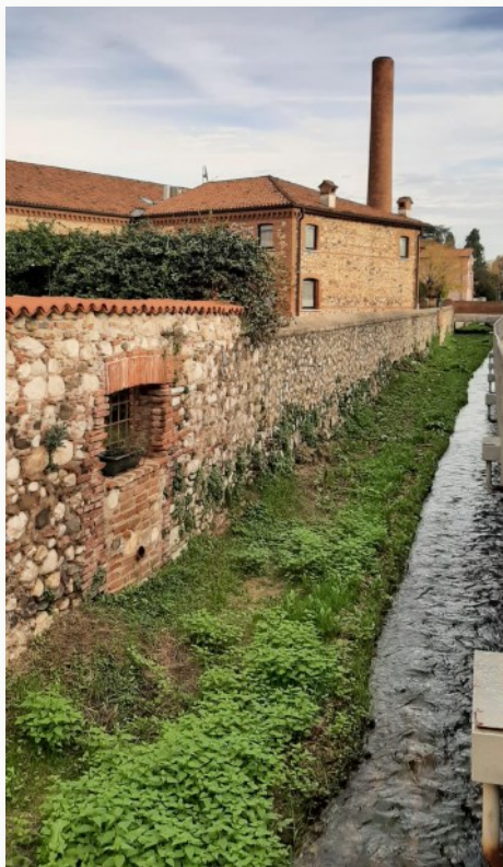
Filanda Rossi dopo il restauro
