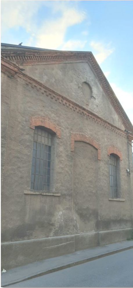
Gli esterni della filanda in Via De Muri
