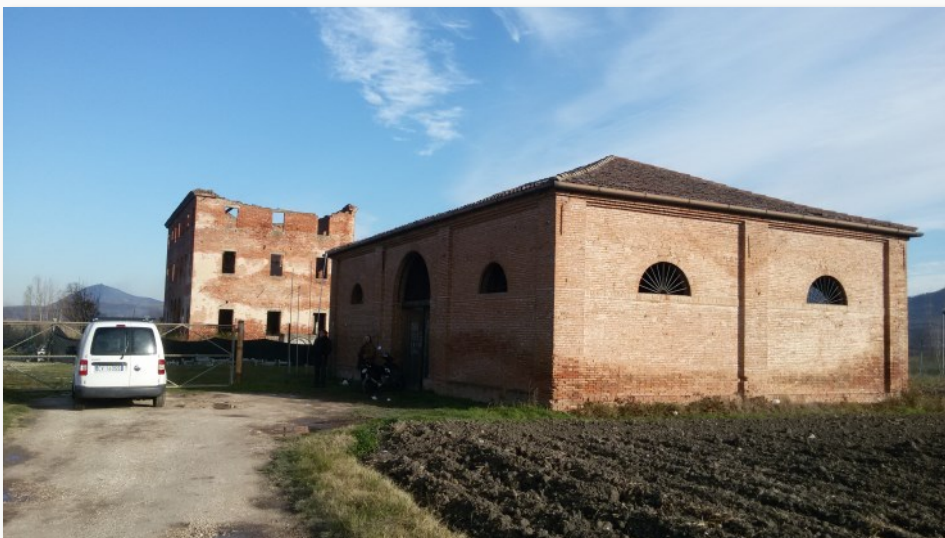
Baone - Terme di Val Calaona
