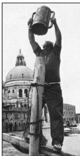
L'antico mestiere del battipalo, oggi sostituito da gru idrauliche
