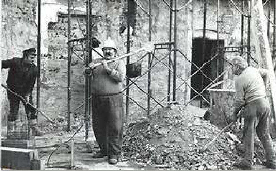
Operai al lavoro nel secolo scorso
