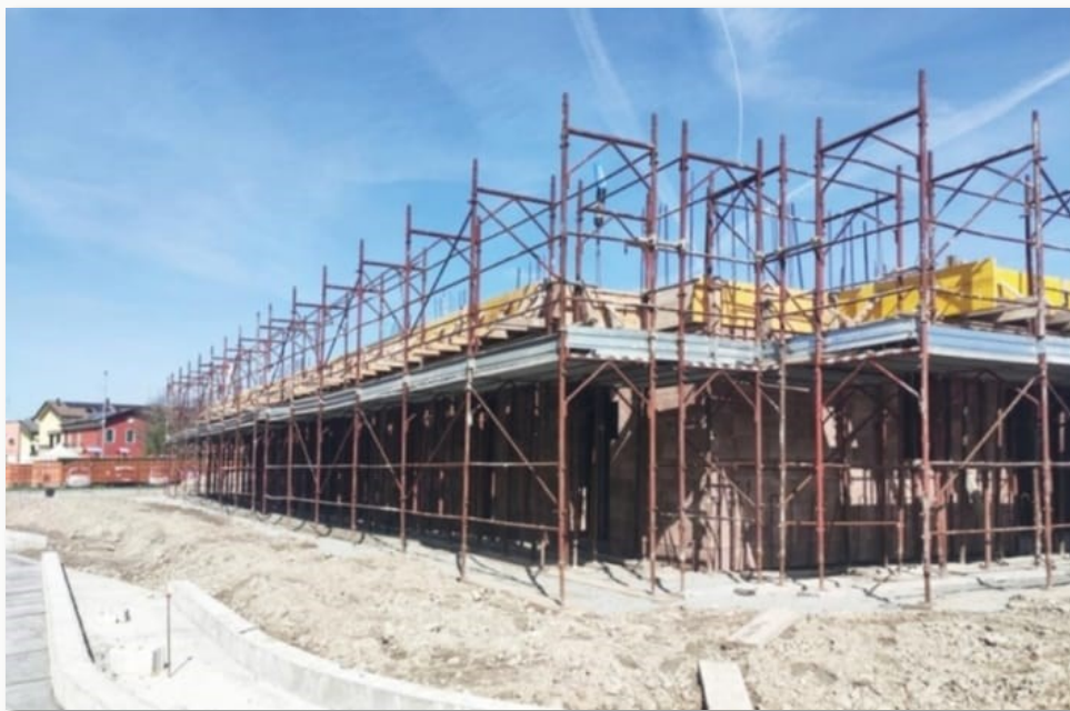
Cantiere di un edificio in costruzione
